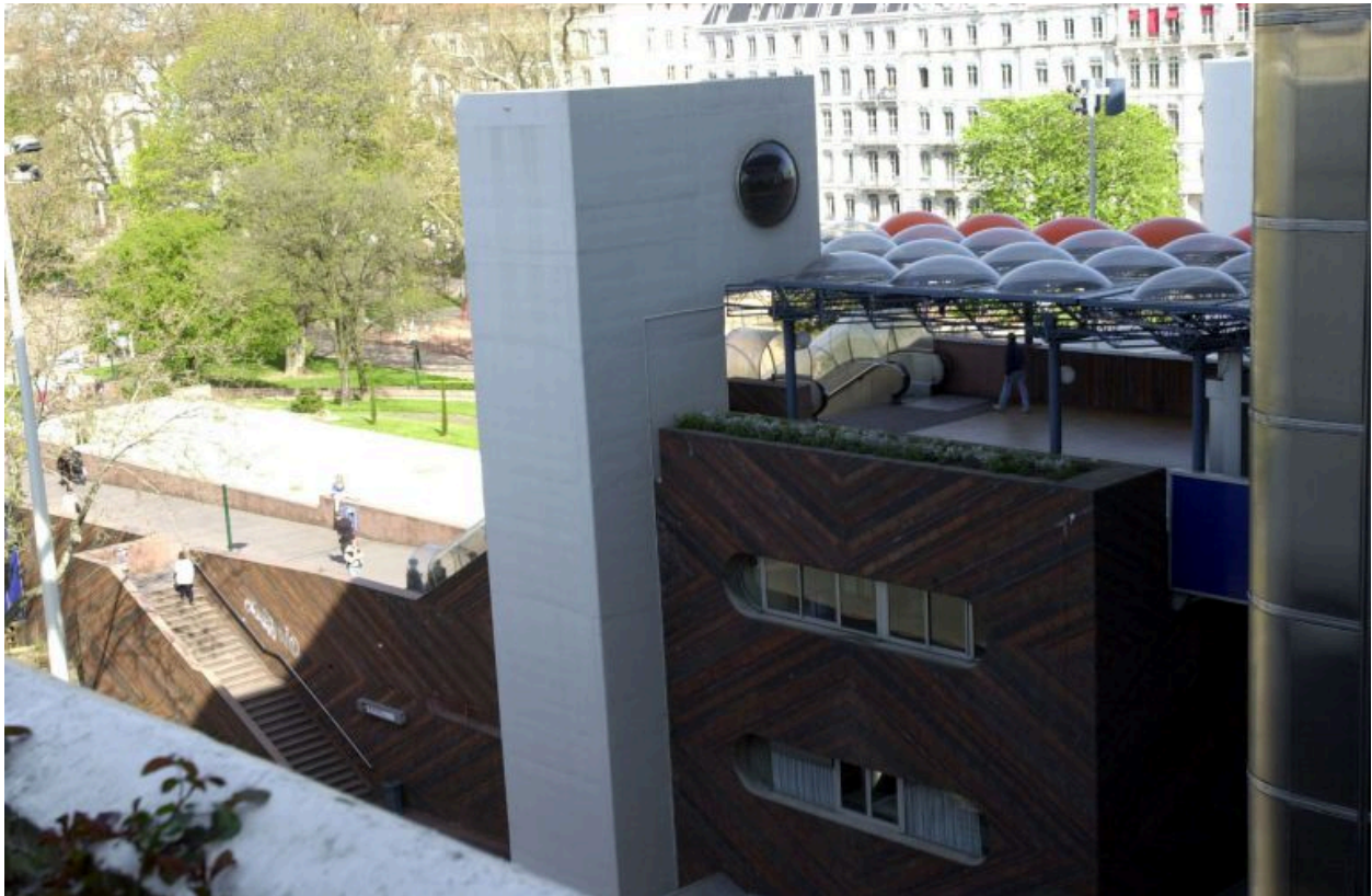
Rampe d'accès au centre d'échanges : vue de la terrasse des jardins
