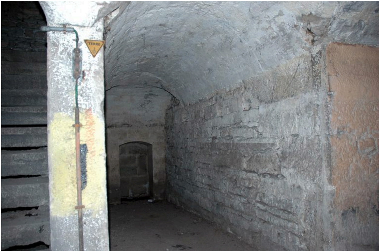
Couvent : 2 rue Gaspard-André, vue d'un passage dans la cave
