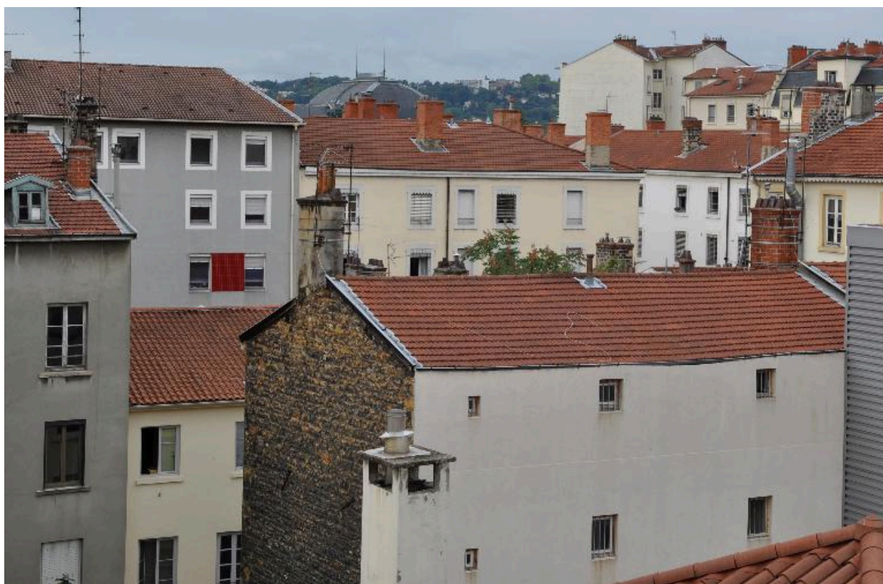
Immeuble sur cour, élévation postérieure et pignon latéral en moellons apparents
