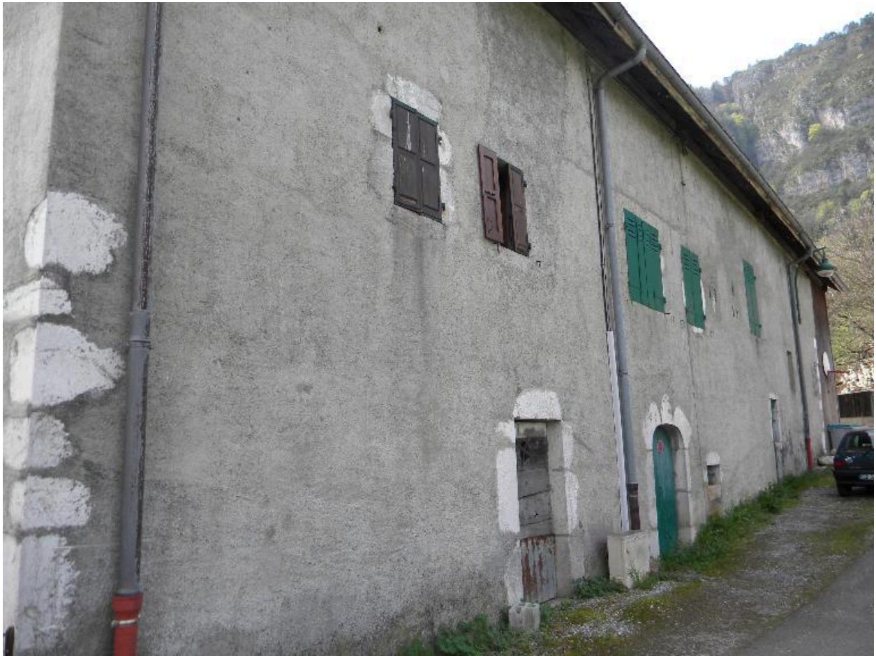
Vue de la façade nord.
