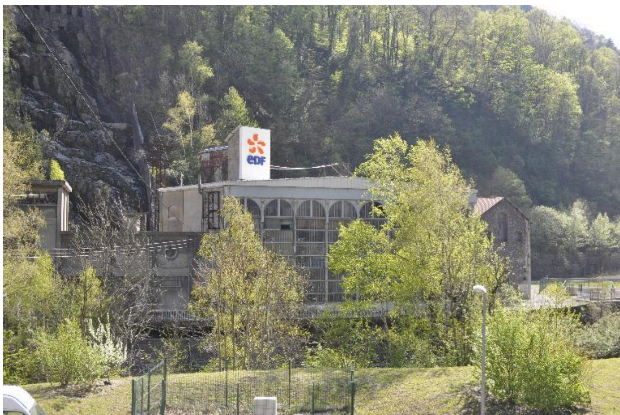
Vue de la centrale
