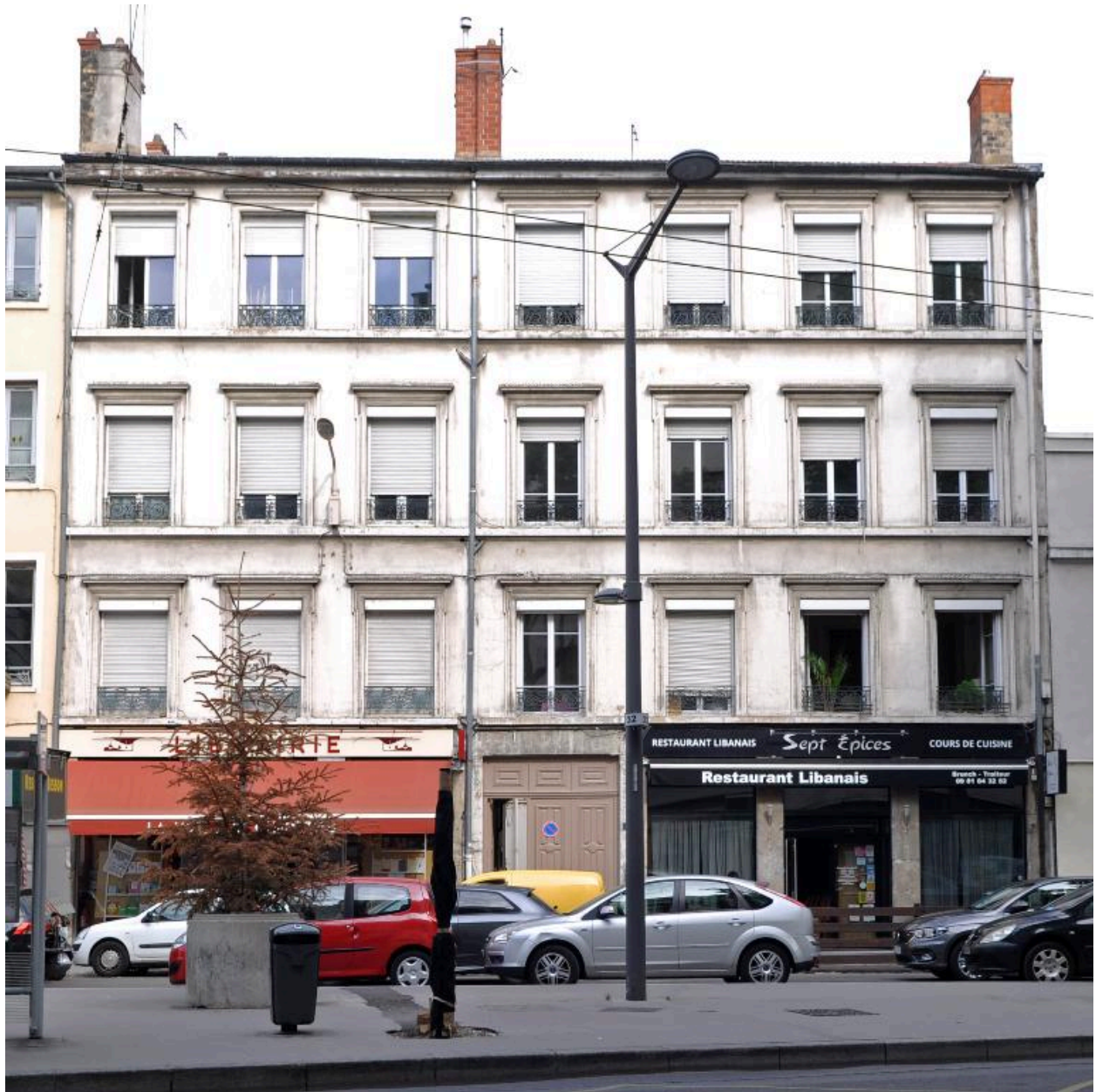
Immeuble sur rue, élévation antérieure
