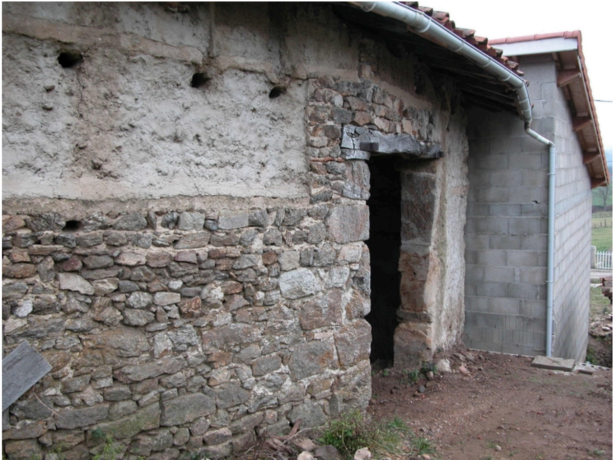
Vue arrière de la grange-étable.
