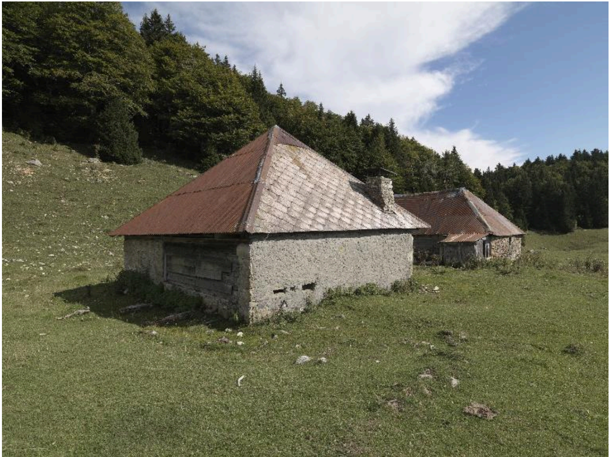
Vue du bâtiment d'habitation et du bâtiment sud.
