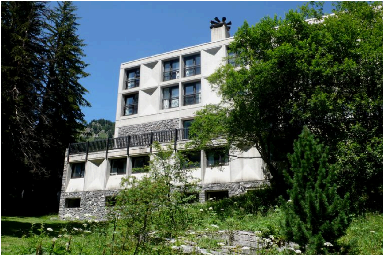
Façade sud, extrémité ouest
