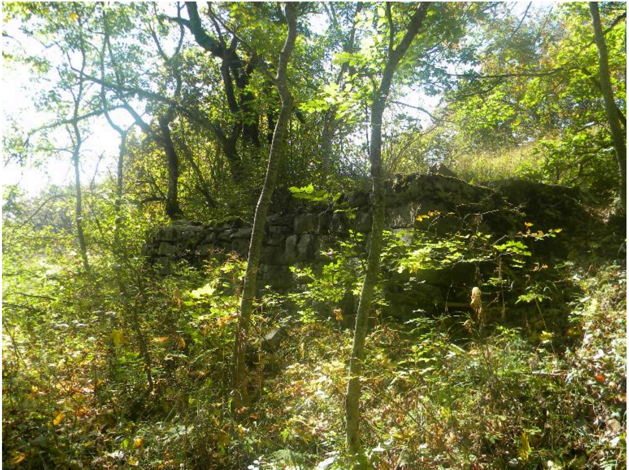
Vue du soubassement d'une grange .
