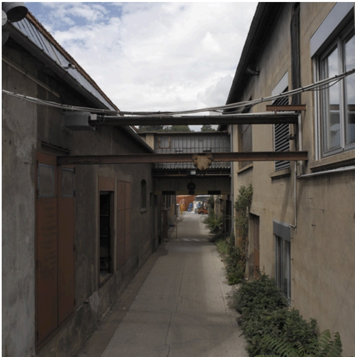
Elément structurel, et passerelle aérienne
