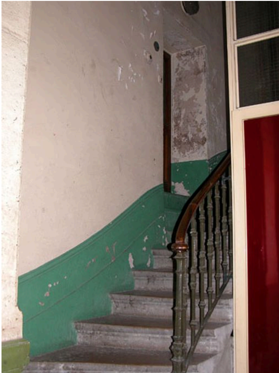
Départ de l'escalier et vue de la porte de la conciergerie
