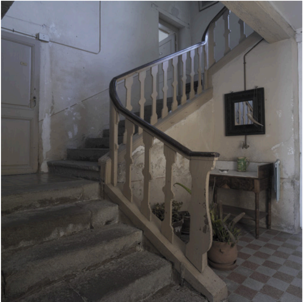
Vue intérieure de l'escalier.
