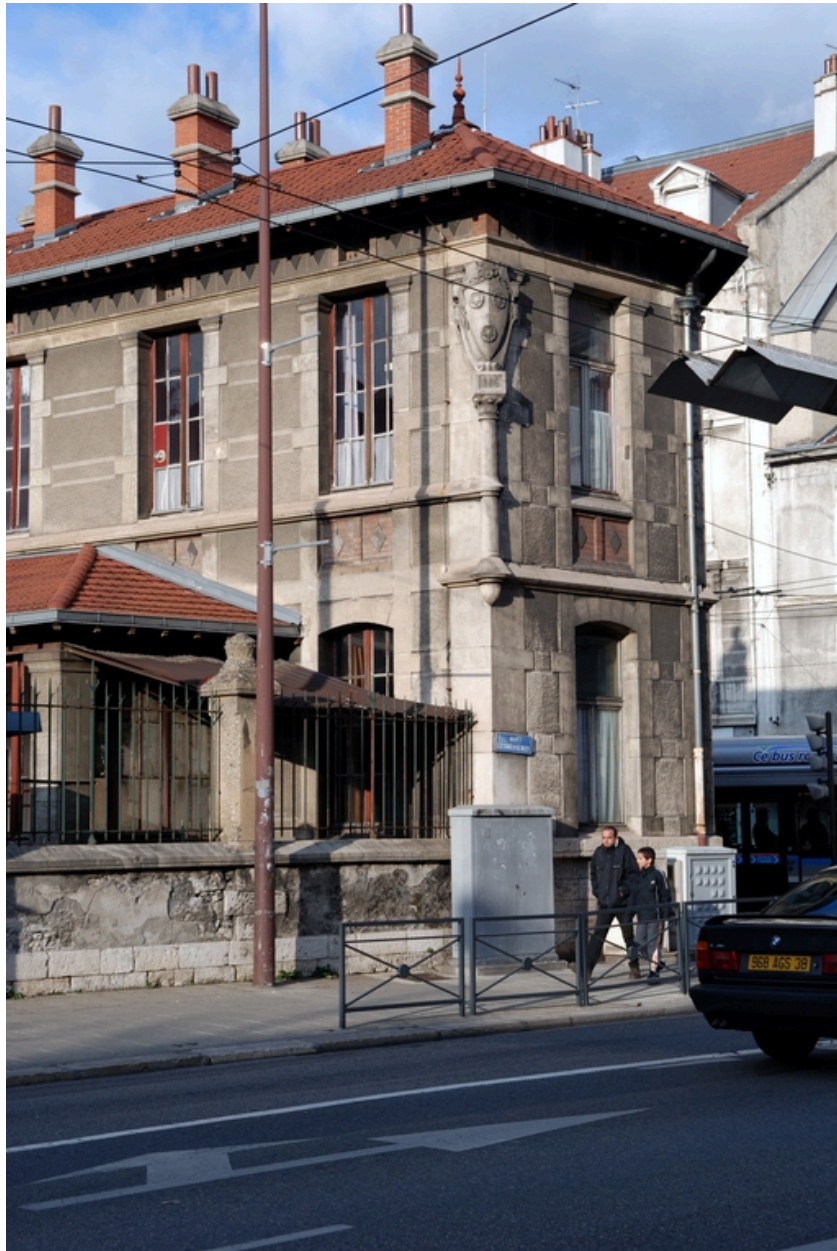
Bâtiment de l'infirmerie, vue partielle depuis la rue Lesdiguières
