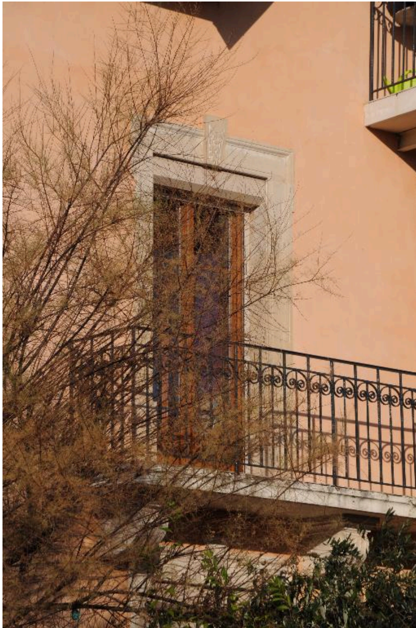
Baie de la façade principale
