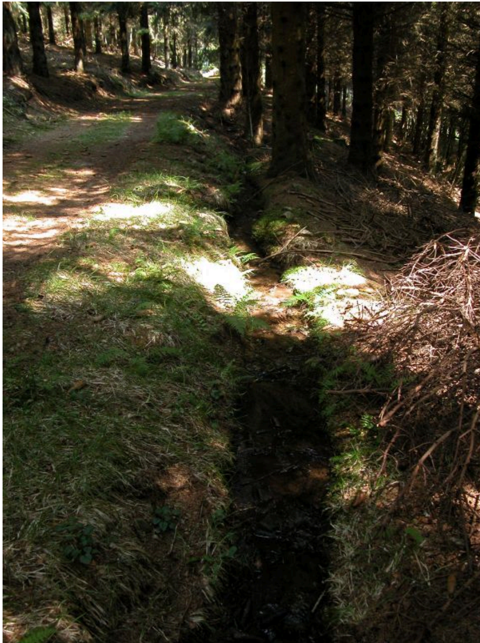
Vue partielle du bief d'amenée d'eau à la bonde.
