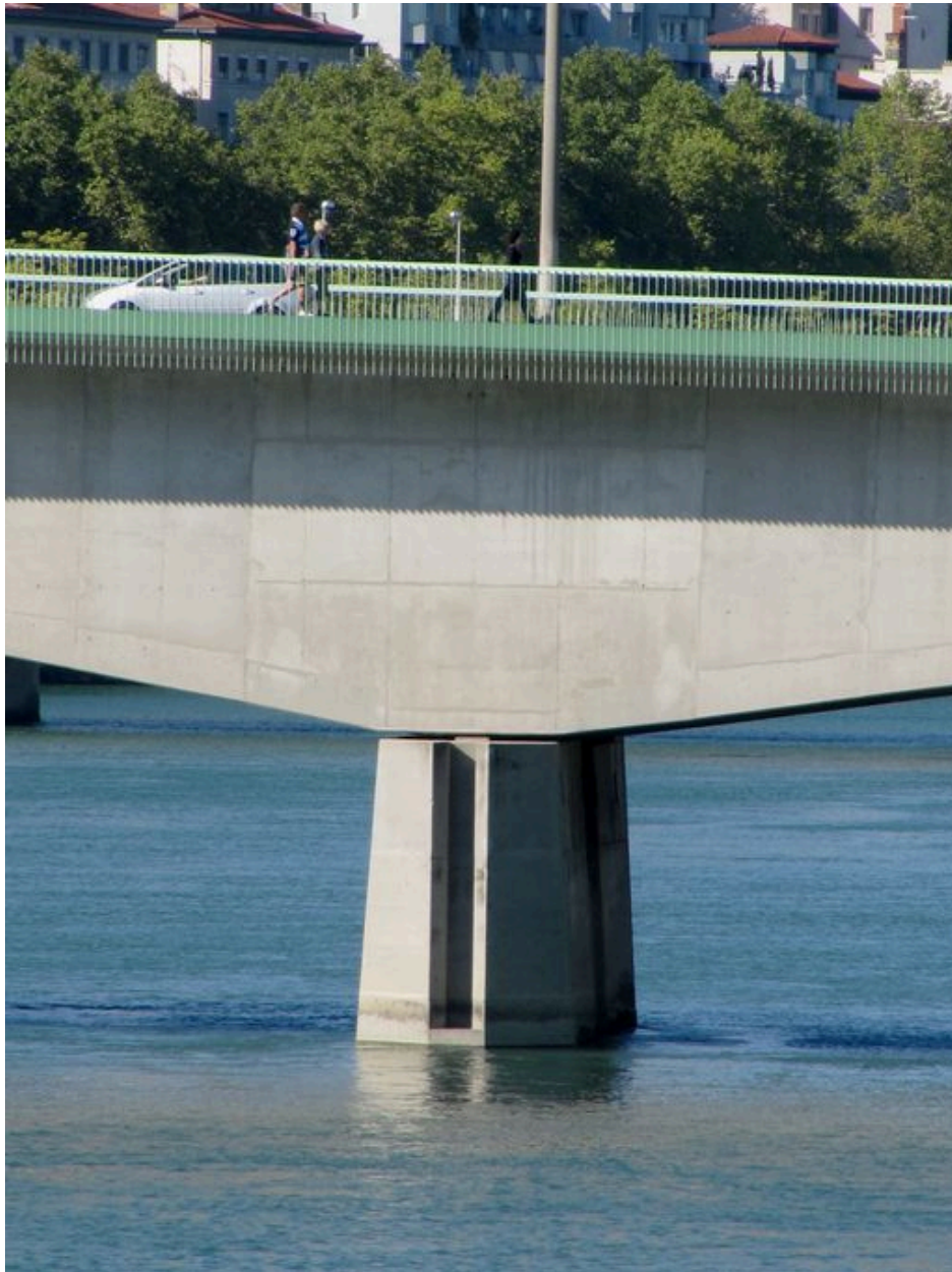
Pile, face aval, vue générale (depuis la passerelle du Collège)
