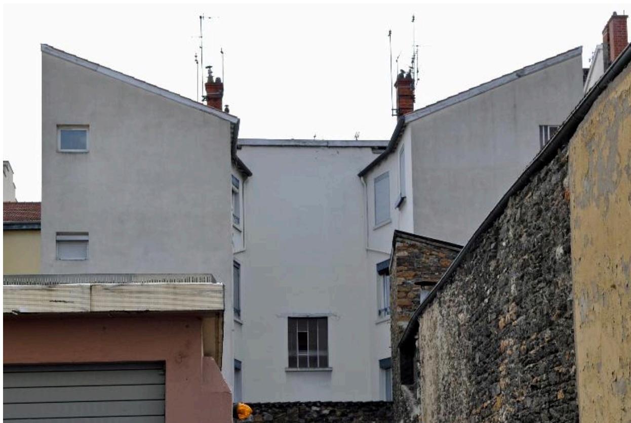
Immeuble sur cour, élévations postérieures
