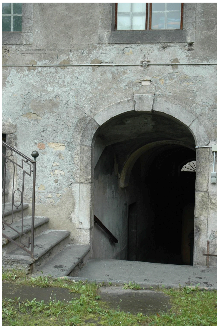
Départ de l'escalier extérieur du logis et passage couvert vers la rue Louis Blanc-Pinget.
