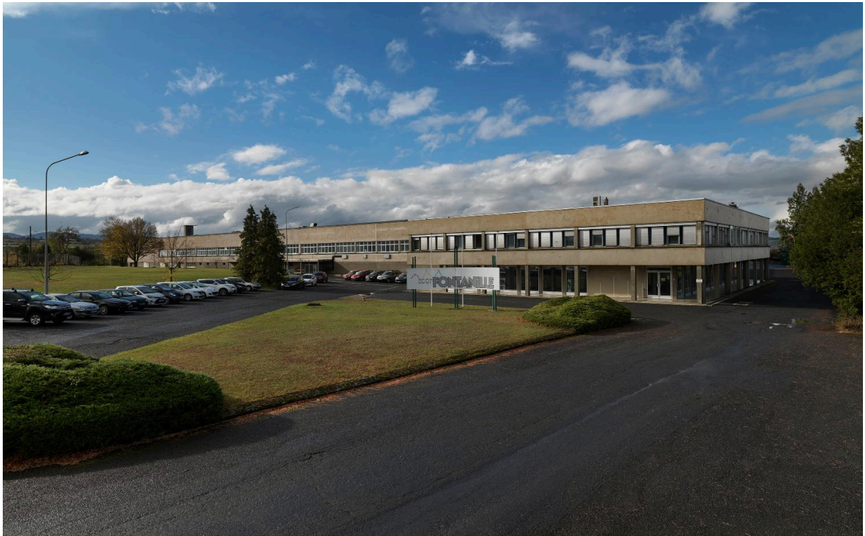
Vue d'ensemble de l'usine Fontanille site d'Espaly-Saint-Marcel
