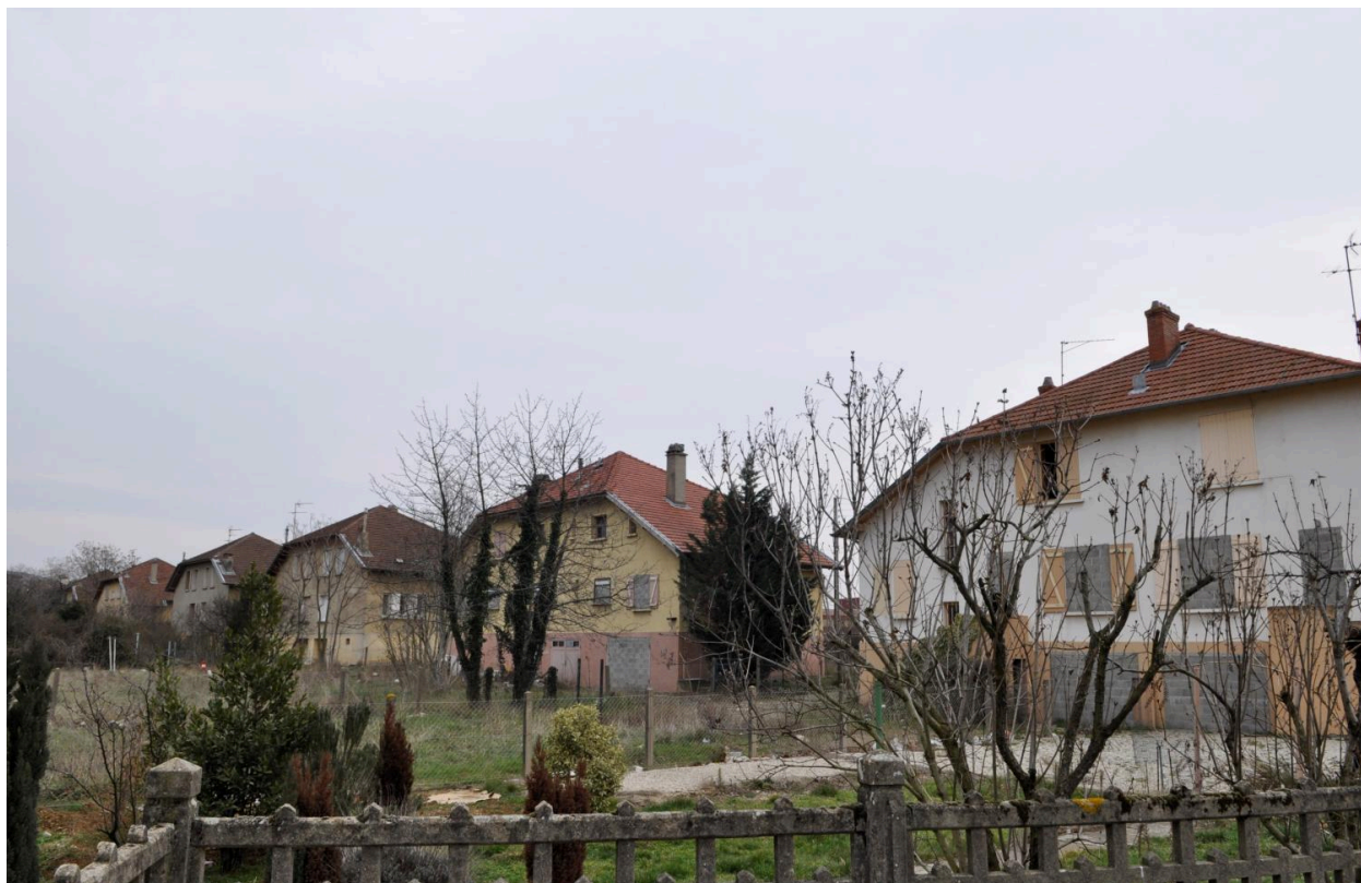
Vue d'extérieur, logements ouvriers, cité EDF
