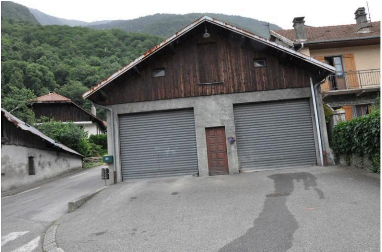
Pignon nord-ouest du bâtiment.
