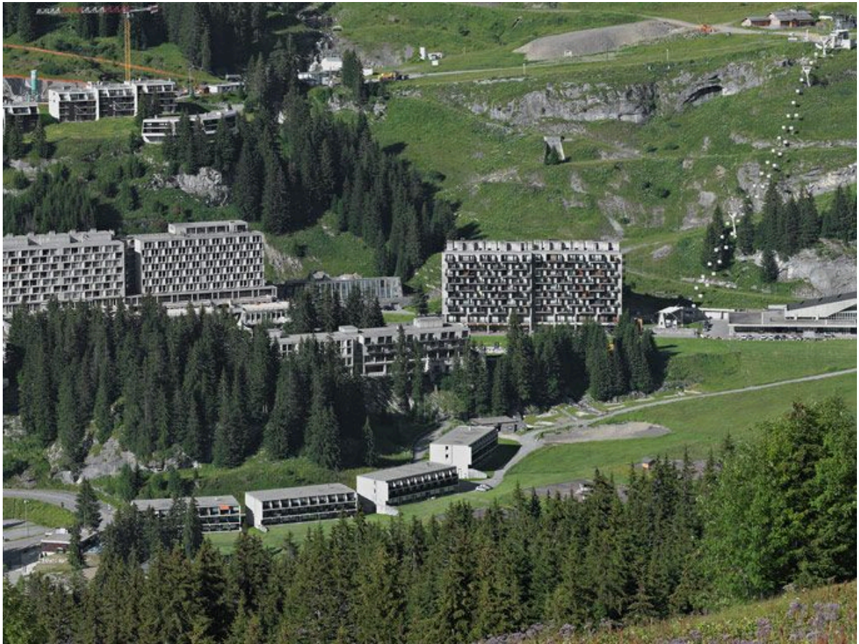
Vue d'ensemble dans le site depuis le sud-ouest
