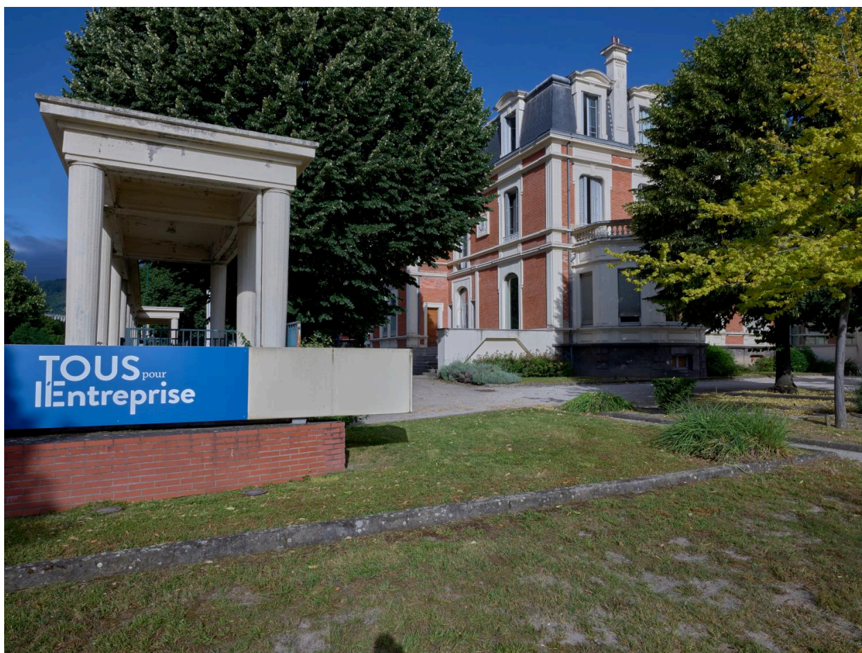
Vue de l'angle sud-ouest et du péristyle d'entrée
