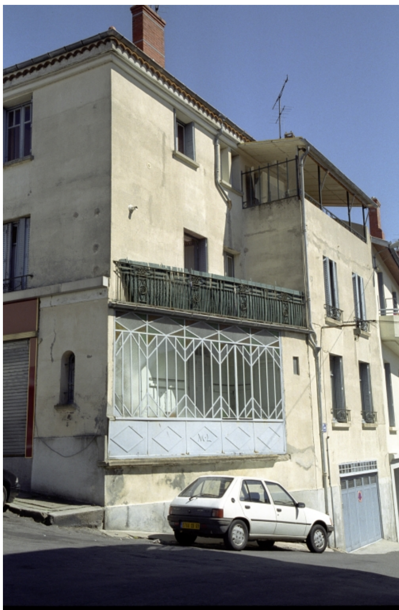
Boën, îlot 14, 11 Novembre (rue du) / Parapet (place du) / Gustave Labrosse (rue). Vue générale des façades sur rue.
