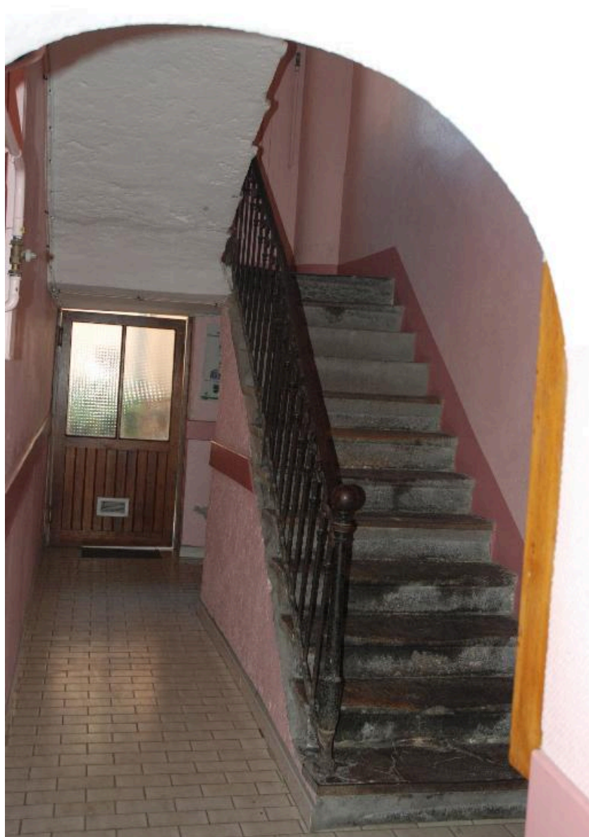
Vue du départ de l'escalier
