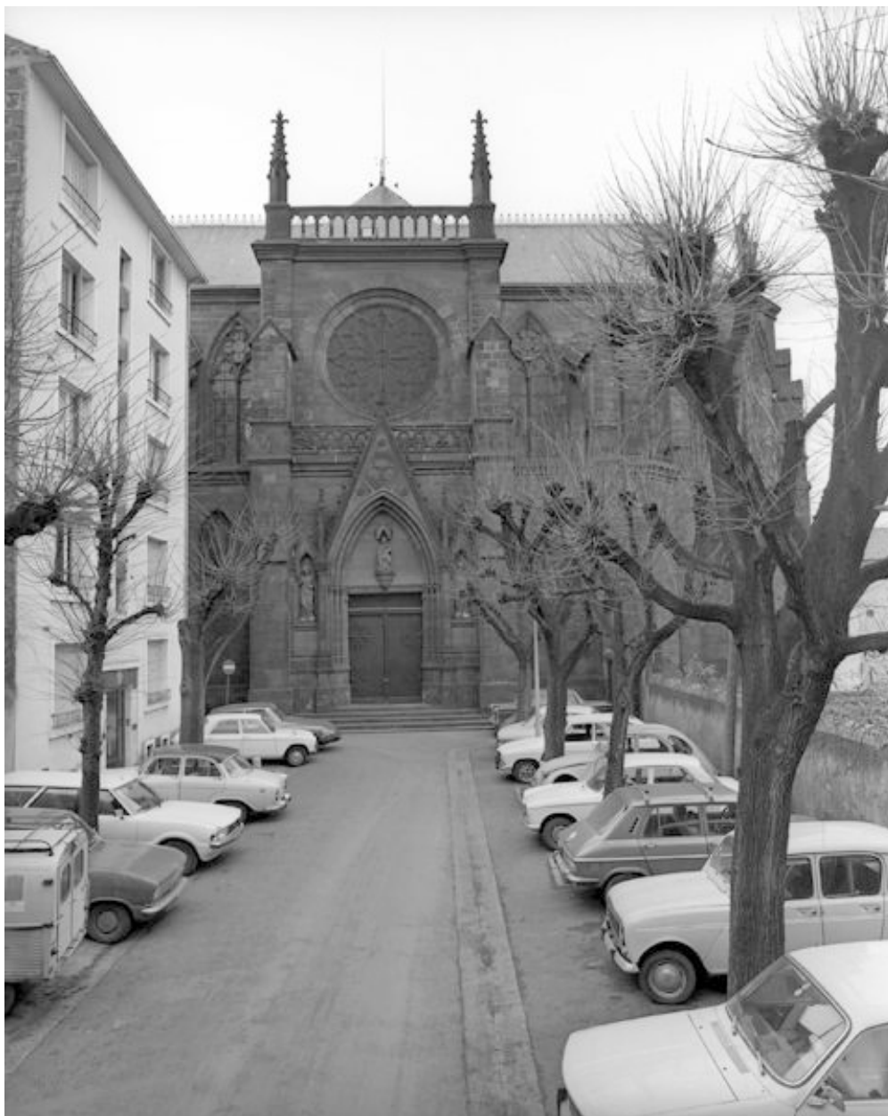
Vue d'une façade latérale
