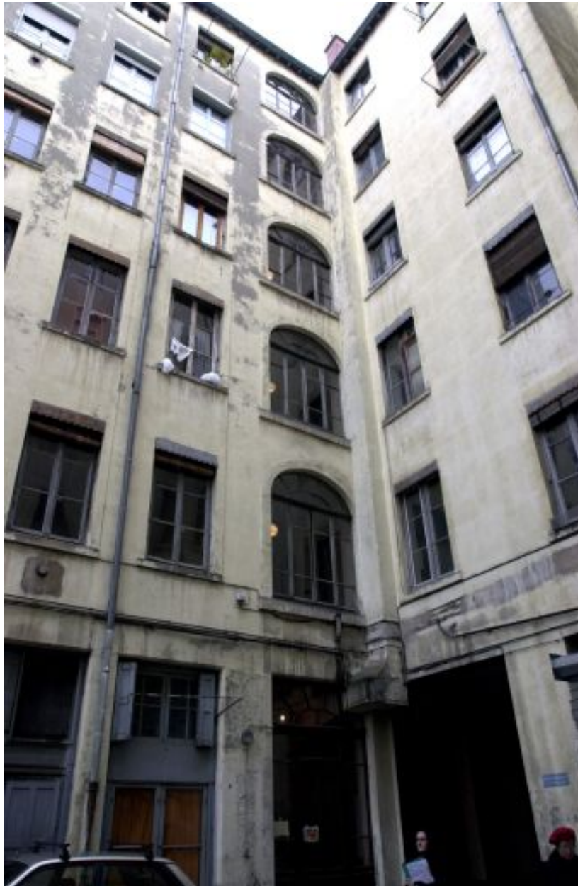
Vue de la travée d'escalier du 25 cours Suchet depuis l'angle sud-ouest de la cour
