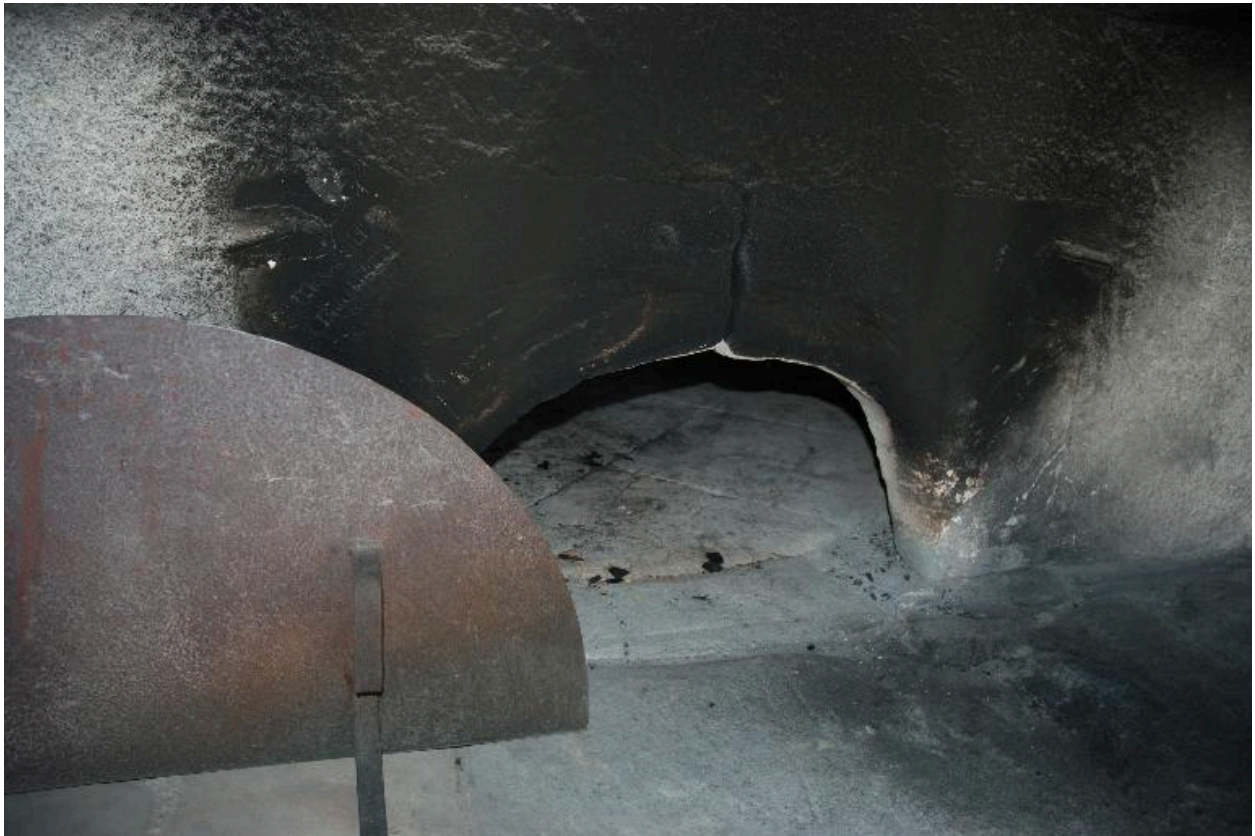
Détail de la bouche d'entrée du four.
