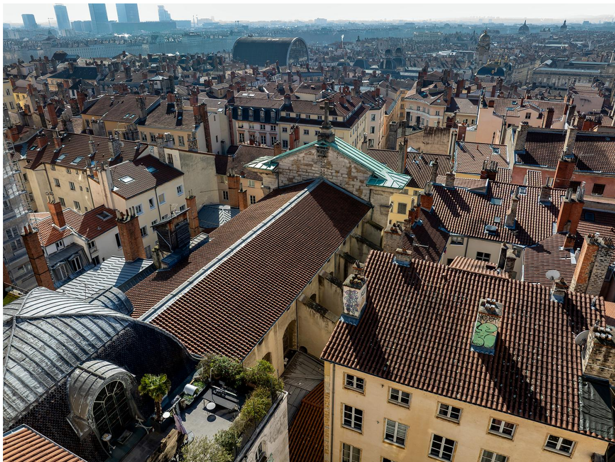
Vue aérienne de l'église Saint-Polycarpe du nord-ouest vers le sud-ouest
