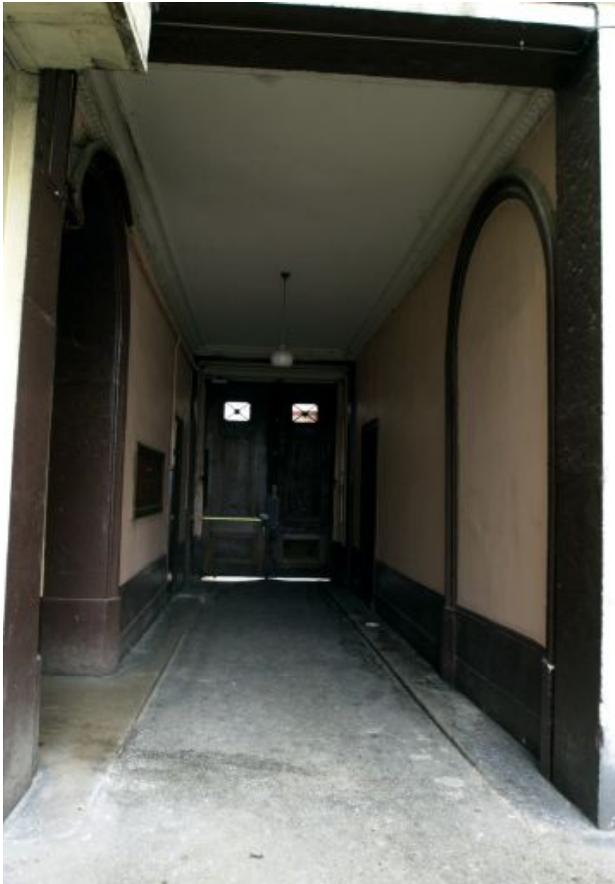
Passage couvert du 9 cours Charlemagne, depuis la cour
