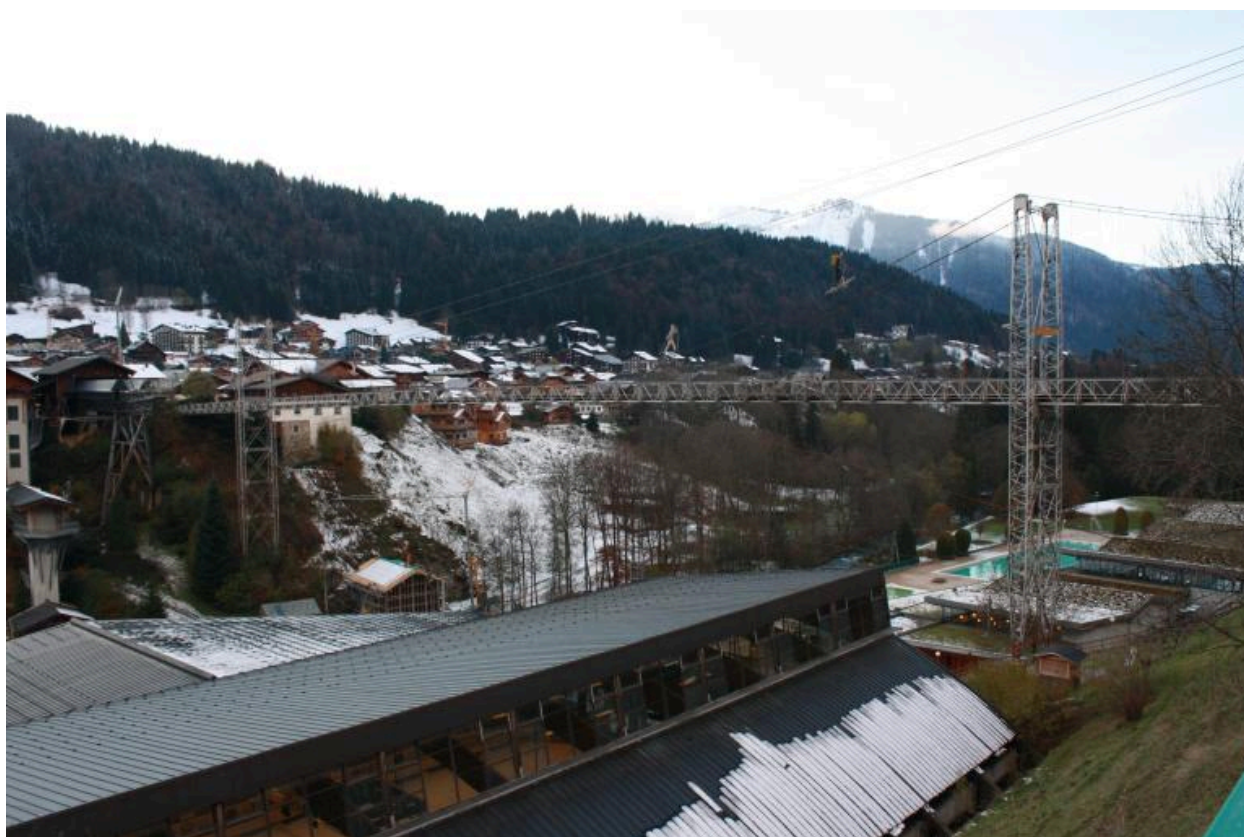
Passerelle François-Baud Grand-Hotel, contexte et face amont
