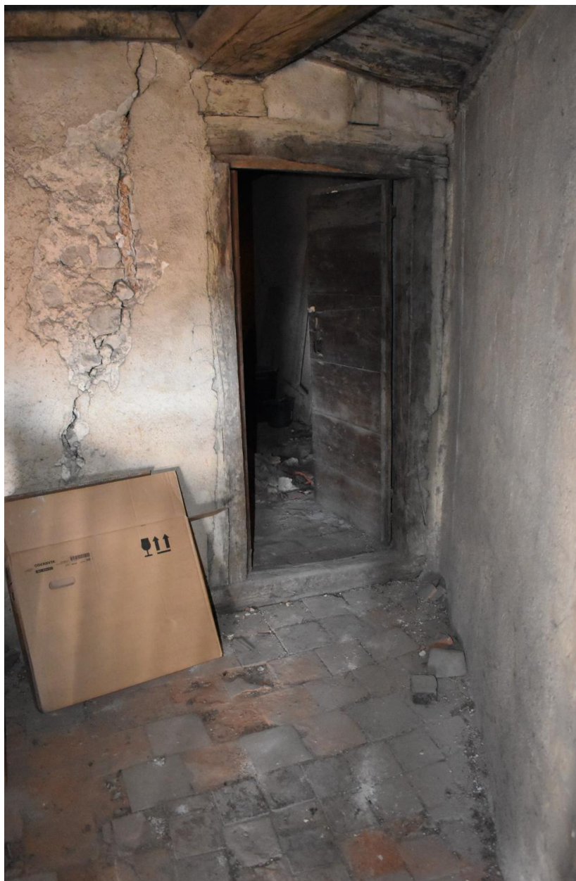
Etage de comble. Espace C avec porte d'accès au palier situé au droit de l'escalier en vis.
