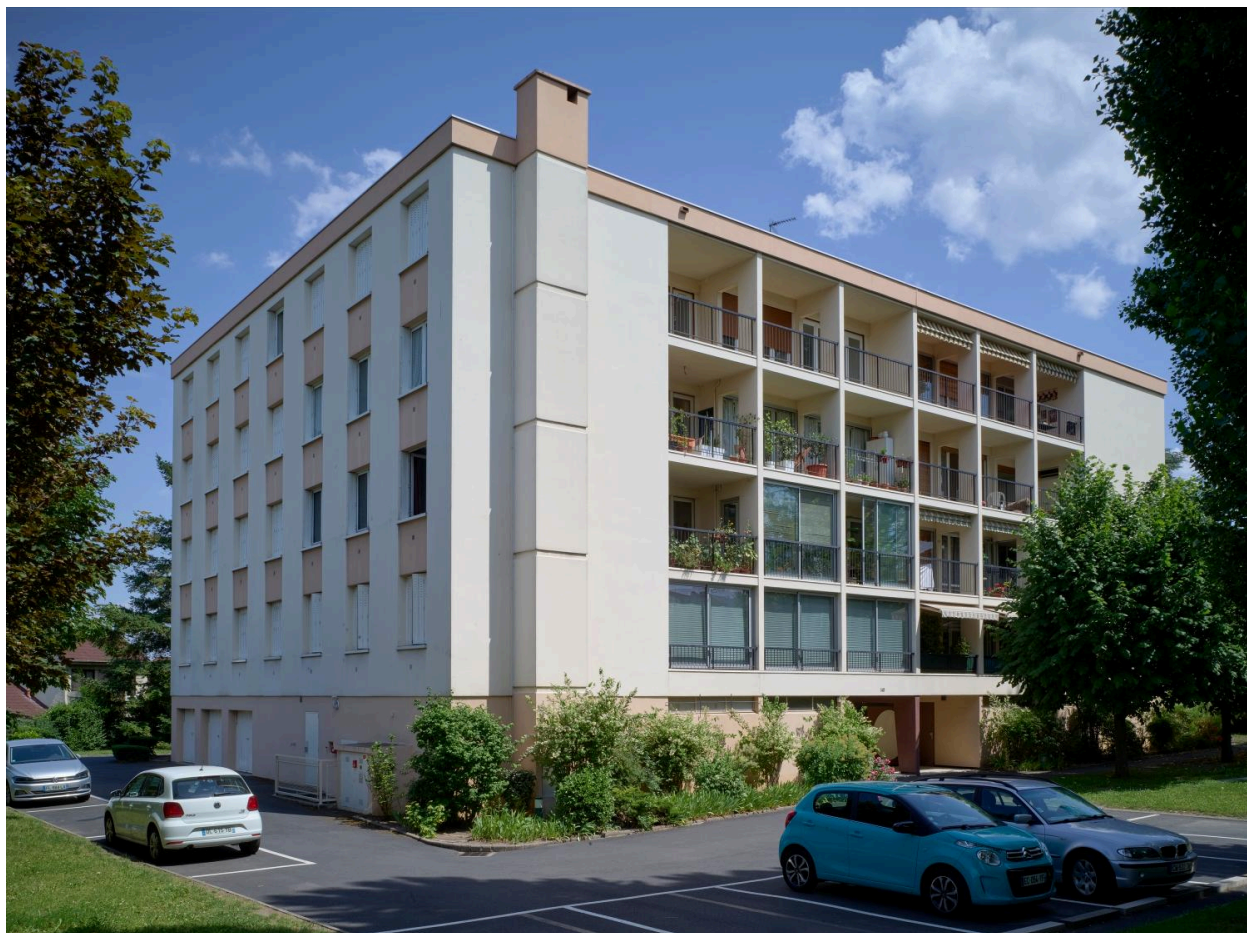
Immeuble de la cité de l'Oradou (1973).
