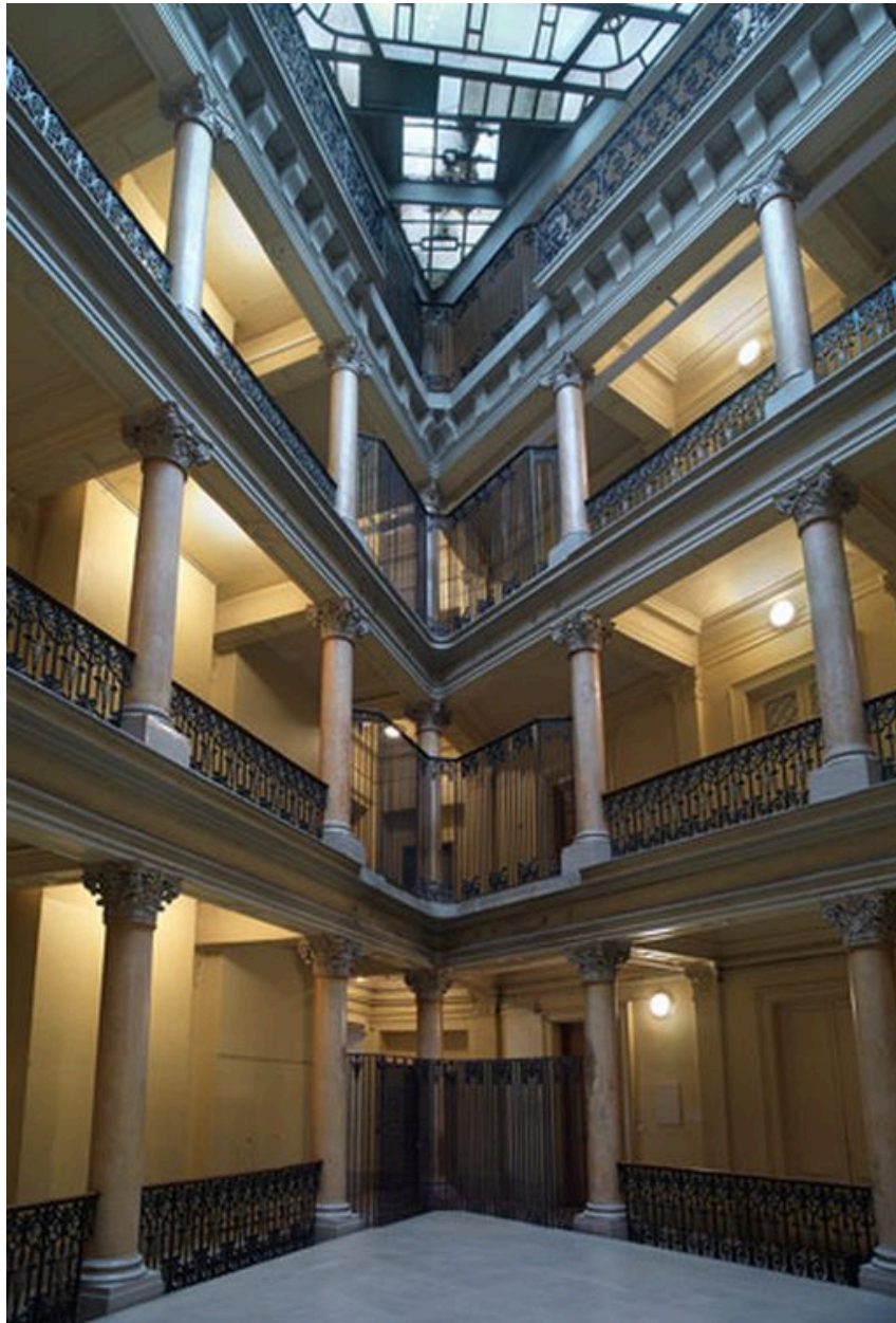
Vue de la colonnade du grand hall (2e, 3e, 4e étages et étage de combles).
