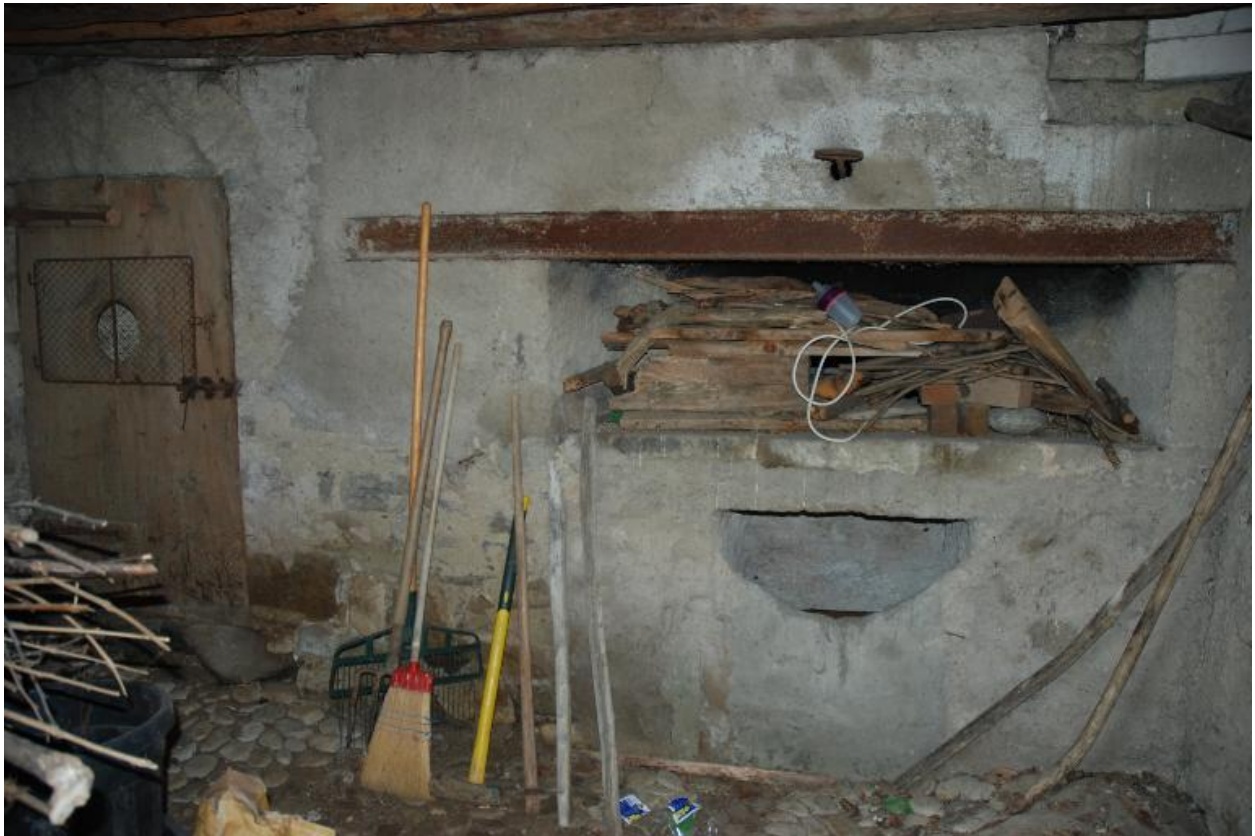
Vue intérieure du four à pain.
