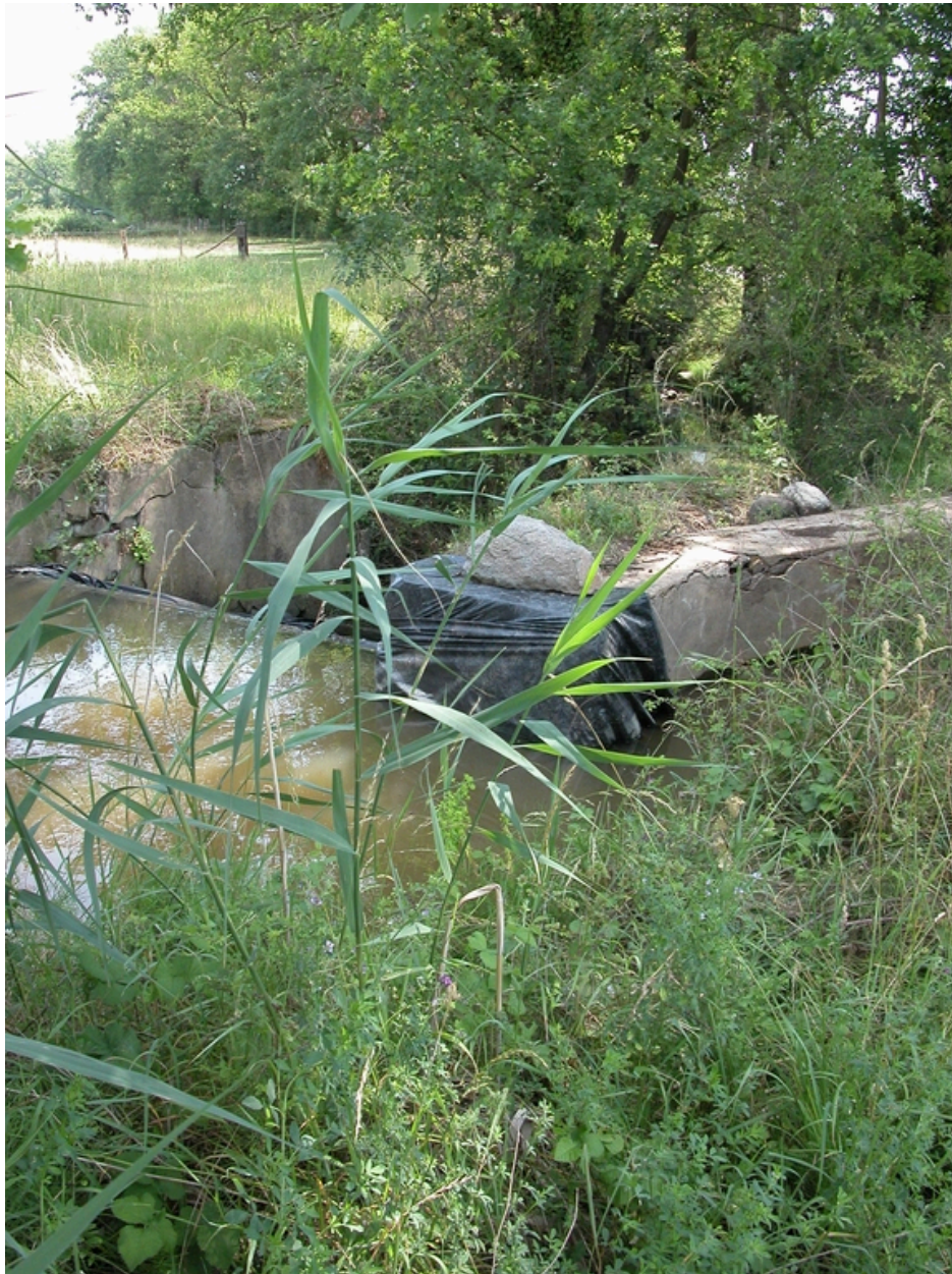
Prise d'eau sur un ruisseau (section ZC, à proximité de l'étang de Vallon).
