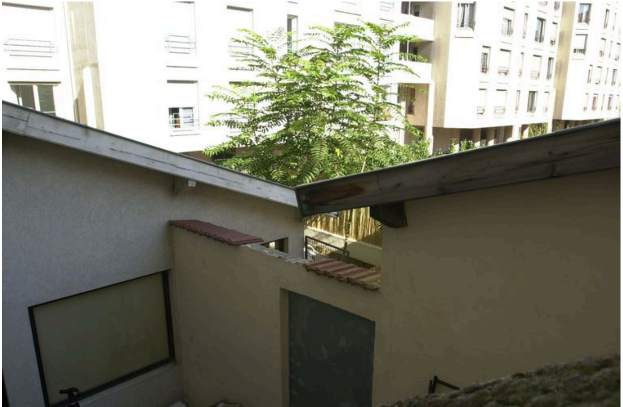
Vue partielle depuis le sud-est
