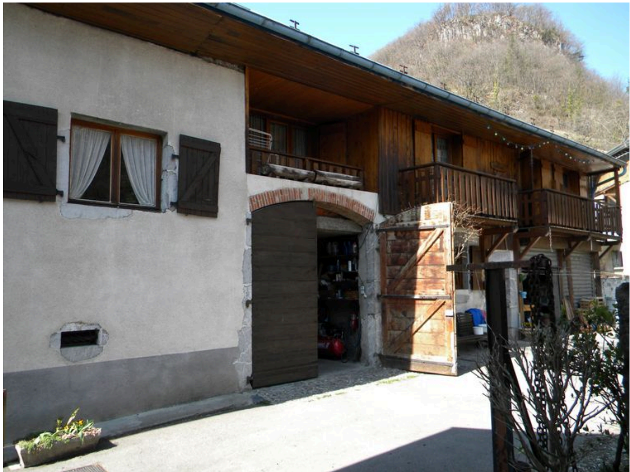
Vue de la partie agricole d'une ancienne ferme à juxtaposition accolée à plusieurs habitations.(A2403, 404, 410)
