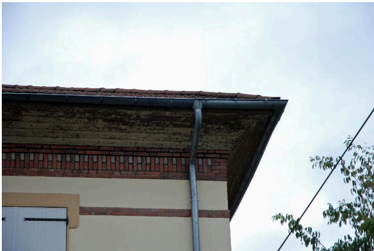
2e immeuble sur cour : détail du décor de briques
