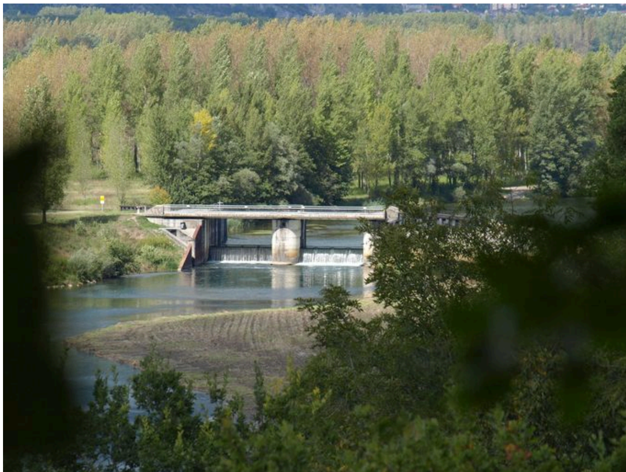
Vue générale du barrage, face aval (depuis la rive gauche)
