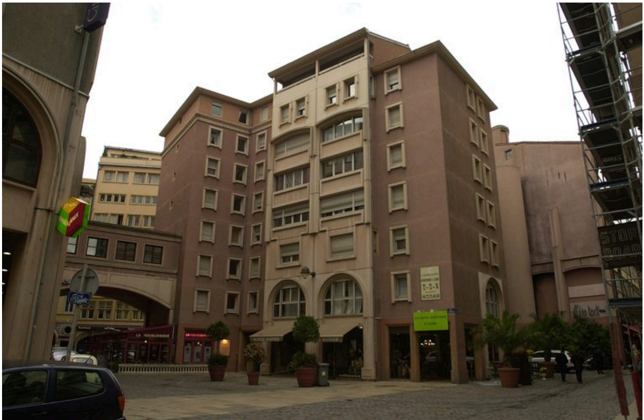
Vue générale depuis la rue Thomassin
