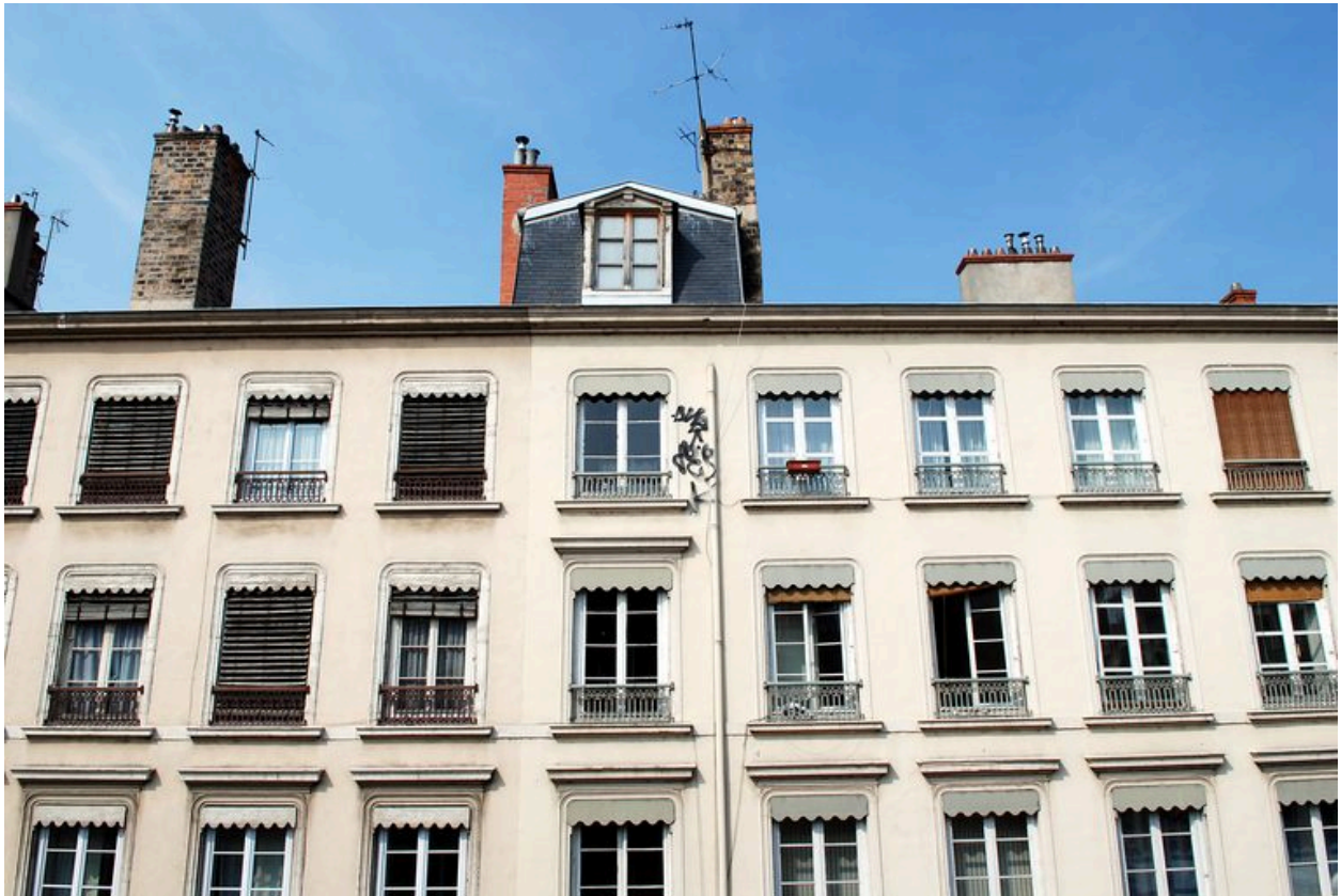
Détail des étages supérieurs depuis la grenette, sise 21 rue de Brest
