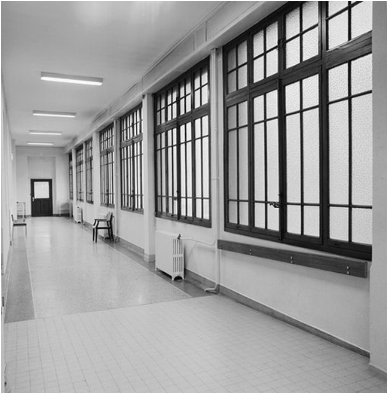
Couloir desservant l'aile nord
