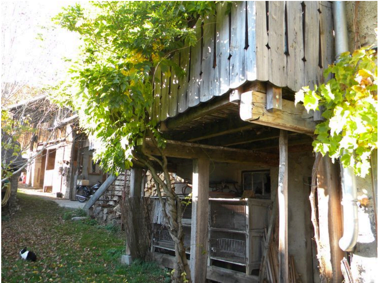
Vue de la façade sud avec une galerie de distribution pour le logement surélevé.
