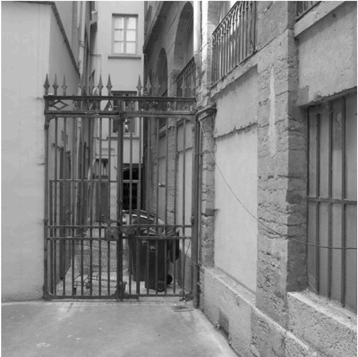
Deuxième cour, portail fermant l'accès à la cour commune du 20, rue Paul-Chenavard
