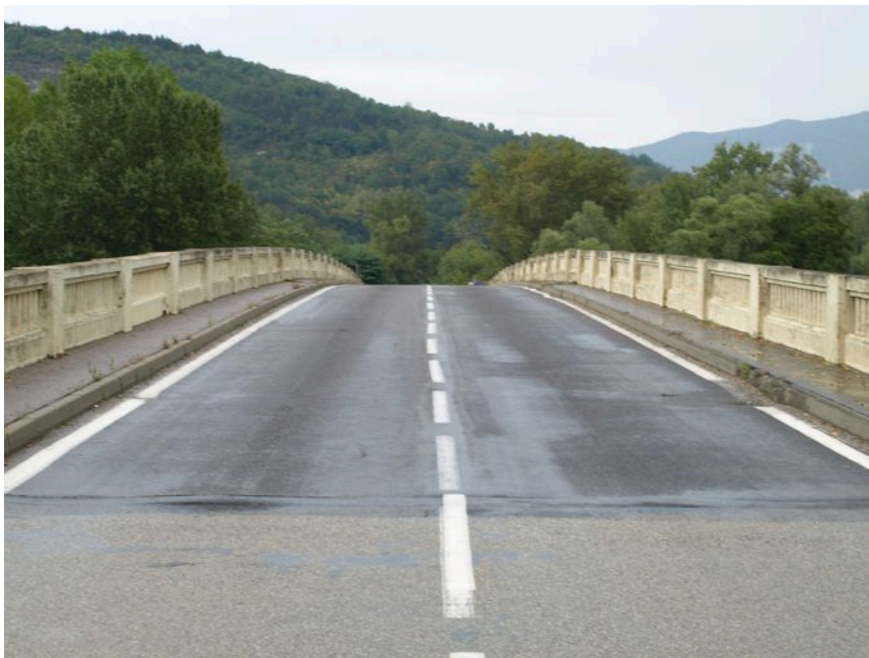
Chaussée (depuis la rive gauche)
