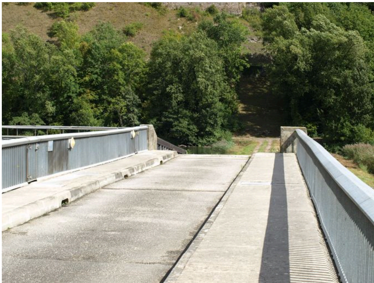
Pont, vue de la chaussée
