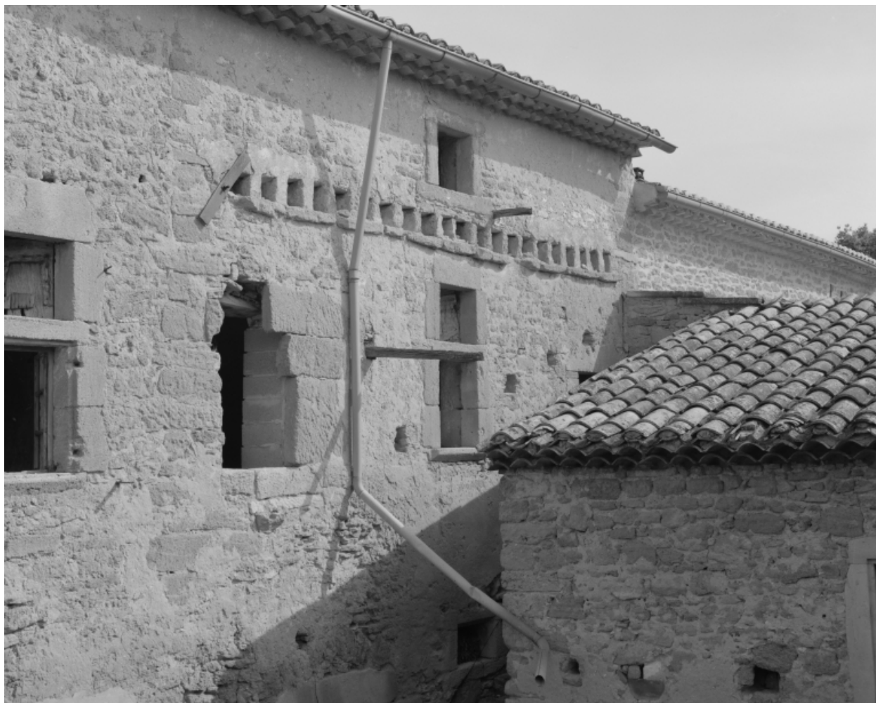
Les Fournaches, détail du pigeonnier en longueur sur la façade (C1 145)
