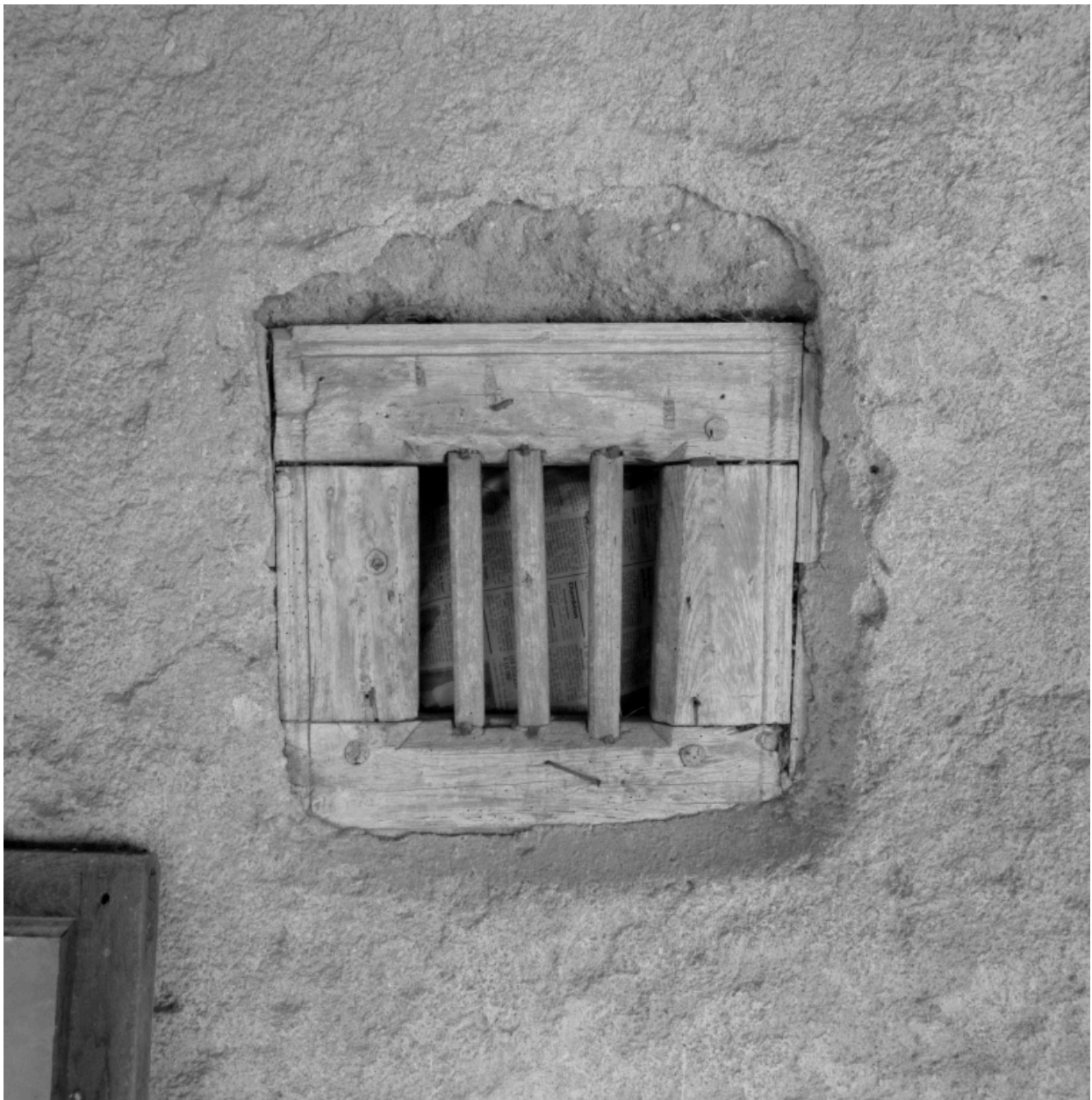
Jour à encadrement et barreaux de bois dans un mur de pisé.
